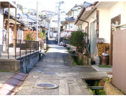
⑦ 両脇に溝蓋のない側溝があり注意
