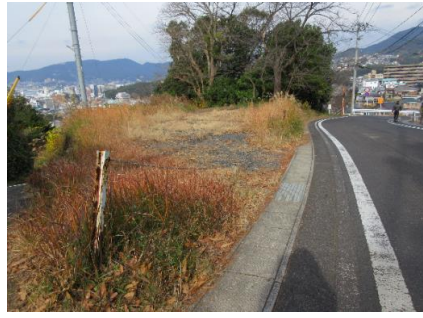
⑭ カーブにより危険 草が多いと歩けない
